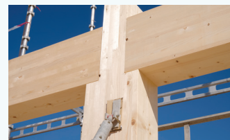
Knutepunktforsterking av stålplater erstatta med opplegg av limtrebjelke på utvida limtresøyler og festa med treskruar. Under montering.
