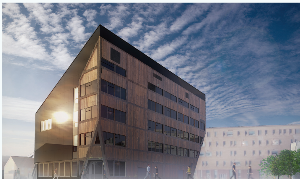
ZEB-laboratoriet til NTNU og SINTEF er under oppføring på Gløshaugen i Trondheim.
