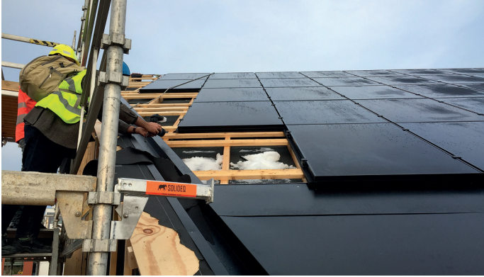
TAK. Bygget har fått en spesiell takkonstruksjon, og er dekket med solceller. Foto: SINTEF
