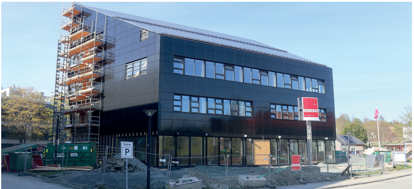
FULLFØRES. ZEB-laboratoriet som nå nærmer seg fullføring i utkanten av universitetsområdet på Gløshaugen i Trondheim.
